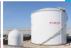
2022年に国内最大の低温アンモニアタンクを竣工
