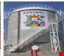
2020年、宮城・気仙沼に国内初の耐津波構造タンク5基を竣工
