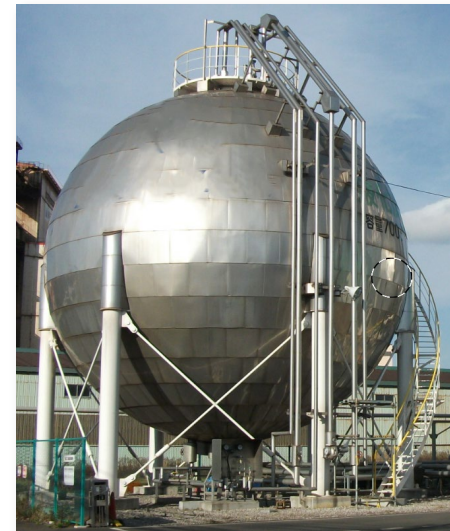
現在、液化炭酸ガス球形タンクを計3基建設中
