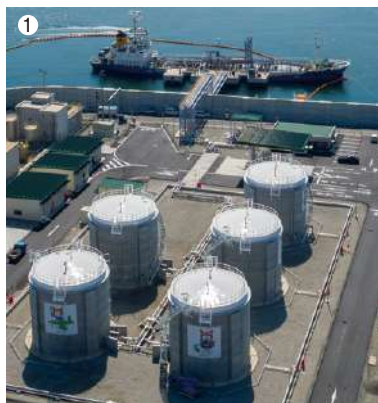
①耐津波構造タンク （株式会社気仙沼商会 気仙沼油槽所） ②液化炭酸ガス球形タンク（高压タンク） ③PS式LPG 低温タンク
