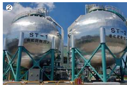
①耐津波構造タンク （株式会社気仙沼商会 気仙沼油槽所） ②液化炭酸ガス球形タンク（高压タンク） ③PS式LPG 低温タンク
