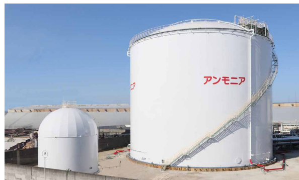
石井鐵工所が23年に化学大手に納入した国内最大規模のアンモニア貯蔵タンク
