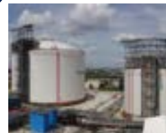
シンガポールで2015年に竣工した低温タンクターミナル
