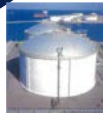
PSコンクリート製低温タンク。1978年に(社)石油学会技術進歩賞など相次いで権威ある賞を受賞
