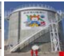
2020年、宮城・気仙沼に国内初の耐津波構造タンク5基を竣工
